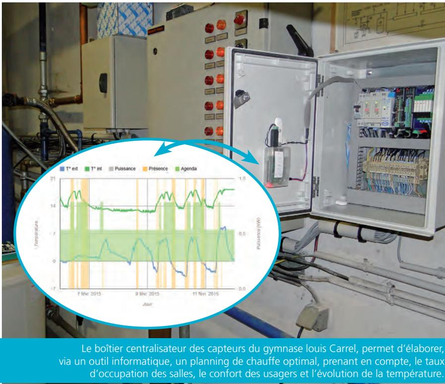
Le boîtier centralisateur des capteurs du gymnase Louis Carrel, permet d'élaborer, via un outil informatique, un planning de chauffe optimal, prenant en compte, le taux d'occupation des salles, le confort des usagers et l'évolution de la température.
