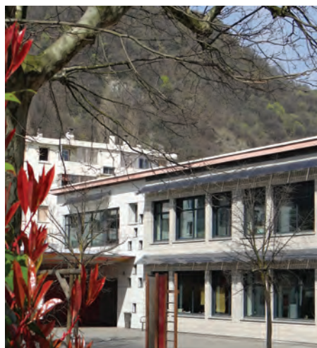
Les panneaux photovoltaïques sur la façade de l'école Moucherotte
