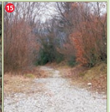
Le GR9 passe au dessus de l'ancienne voie du tram et notamment à cet endroit au dessus du grand tunnel.
