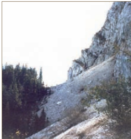
Entrée du vallon des Forges
