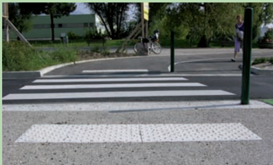
Bandes podotactiles, potelets et abaissement de trottoirs, avenue du Vercors
