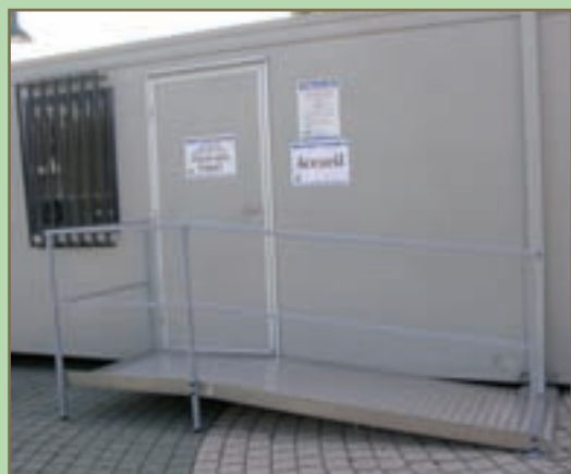
Accessibilité du bungalow d'accueil pendant les travaux
